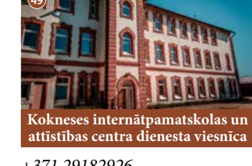
Kokneses internātpamatskolas un attīstības centra dienesta viesnīca
