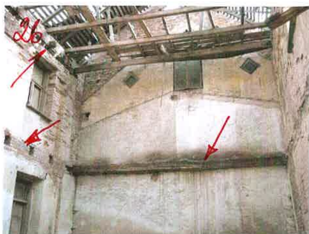
26 BENINU PĀRSEGUMS DAĻĒĀ SATRUPĒJIS VAI IZJĀGĒTS.
