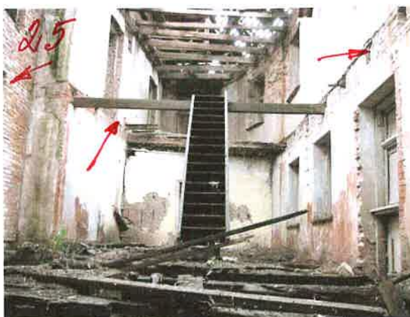
24 STARPSĪVU PĀRSEGUMS IEBRUCIS.
