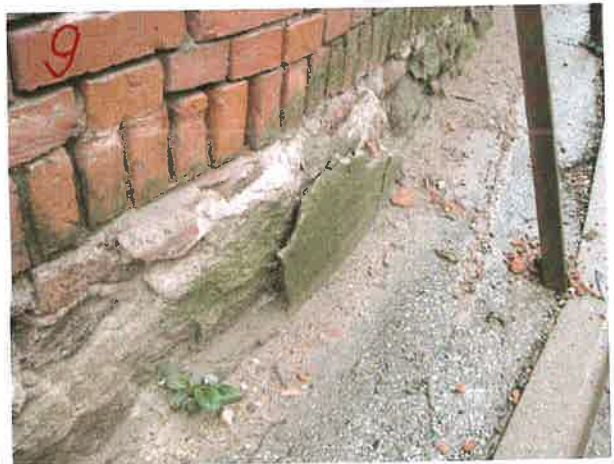
7 PAMATU BETONA PASTIPRINĀJUMS.
