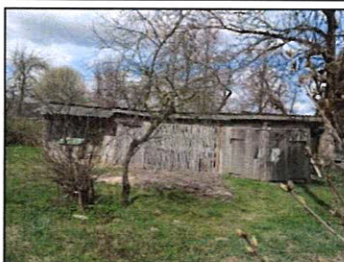
Zemesgrāmatas nodaļījumā neregistrētā šķūņa ēka
